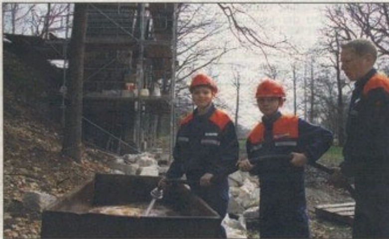
Die Jugendfeuerwehr packt mit an: Damit die Bauleute auch Wasser für den Mörtel haben, pumpen Marcel Werner (links), Leopold Unger und Felix Mulansky von der Dürrröhrsdorfer Jugendfeuerwehr einen Behälter voll.
